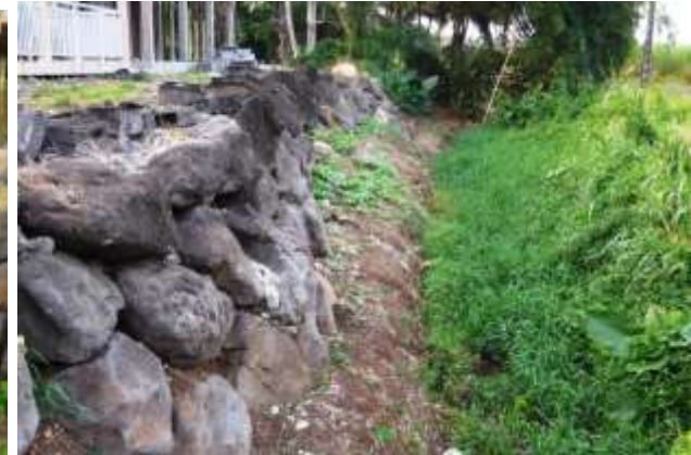
Aménagement par enrochement du cours d'eau . Comme mesures de stabilisation des berges, de protection contre l'affouillement et contre l'inondation du bâti
