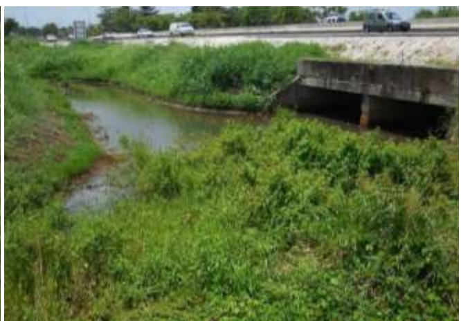
Franchissement sous le pont de la RN1 au niveau de la confluence avec la Ravine Haussou. Cette plaine d'expansion assure une fonction de stockage des eaux. La végétation du canal est constituée d'une strate herbacée
