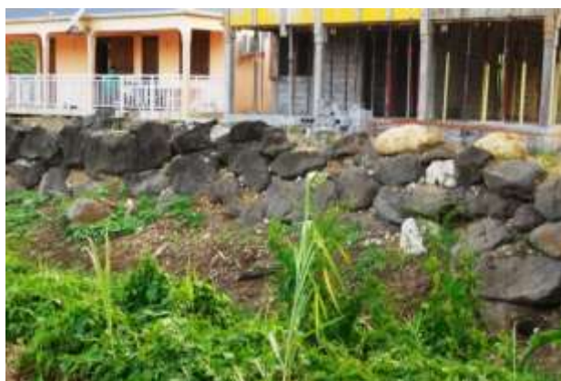
Aménagement par enrochement du cours d'eau . Comme mesures de stabilisation des berges, de protection contre l'affouillement et contre l'inondation du bâti
