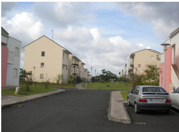
Ensembles intermédiaires sur Bellevue : une rupture avec la trame urbaine du centre autant au niveau de la configuration de l'espace public que des formes bâties
