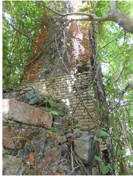
Cheminée en pierres et briques de la distillerie Saint-Jean
